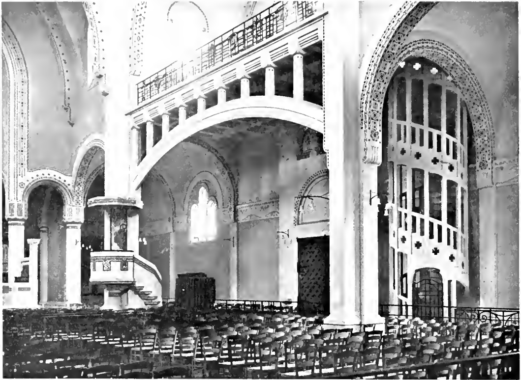
Eglise Saint-Dominique : La tribune et l'escalier.
